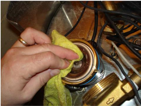
Das Pumpengehäuse sollte auch gesäubert werden. Danach die gereinigte Rotorkugel wieder ins Gehäuse einsetzen.
