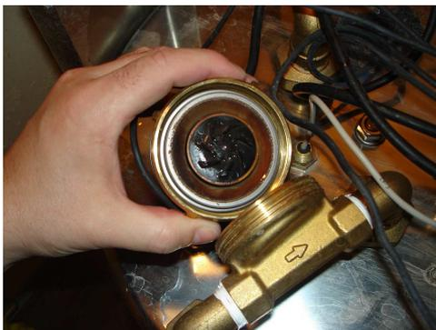
Im Pumpeninneren wird nun die Rotorkugel sichtbar.
